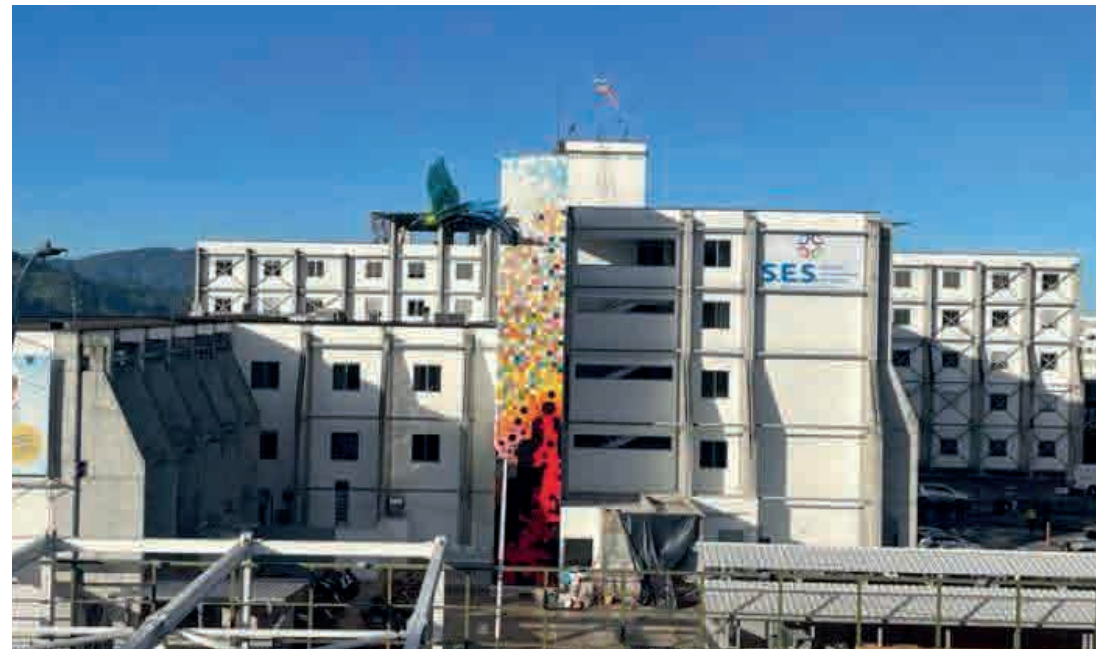
SES Hospital de Caldas
