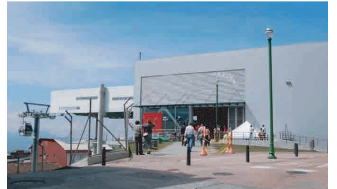
Estación Cable Aereo Fundadores
